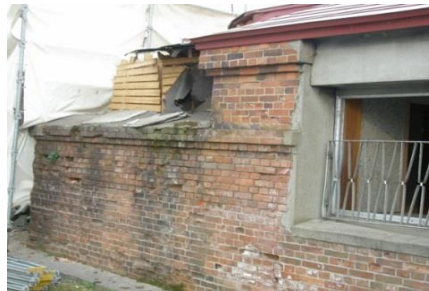
解体作業中のイタリア館
