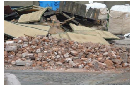
正面の本館側はすでに解体
